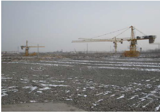
主题园区施工期
