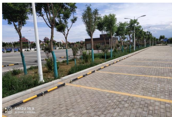
停车场区小车停车位
