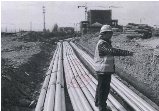
雨水排水管施工
