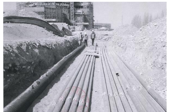
雨水排水管施工
